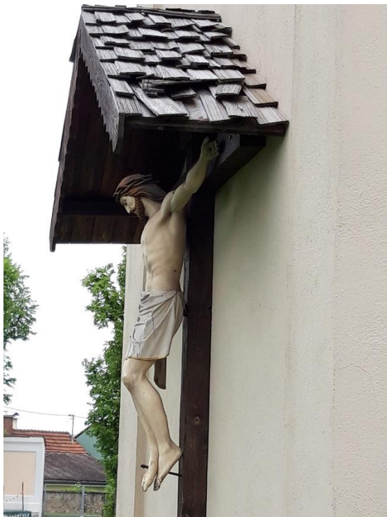
Altes Schindeldach überm Kreuz
